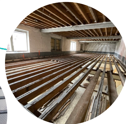
Planches bois pour le support de couverture et traitement sous face Source : Chutes de fabricant de palettes - Velaine en Haye
